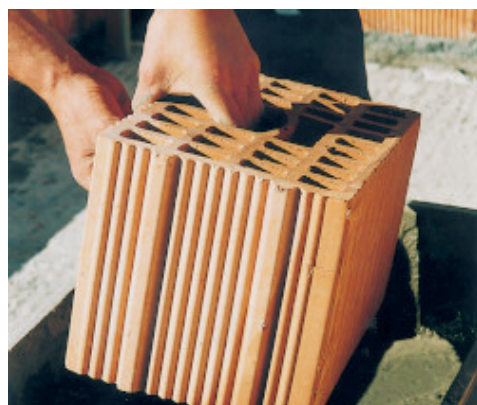
Imersão de bloco em tijolo no Adesilex P4
