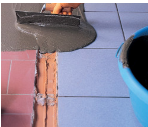
Nivelamento de pavimentos velhos com Adesilex P4
