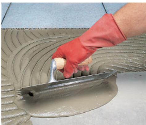
Aplicação com espátula dentado semicircular
